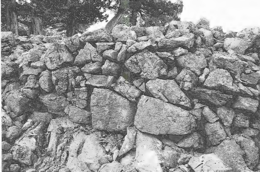
Res. 60 Fası Boğazı Kalesi. Sur duvarları genellikle araziden olduğu gibi toplanan taşlarla inşa edilmiştir.
