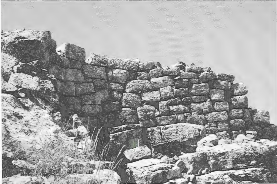
Res. 68 Diğer kale yerleşmelerinin aksine düzgün kesme taşların sur duvarlarında kullanıldığı Tınaztepe kale surları, tepenin topoğrafik yapısına uygun olarak inşa edilmiştir.
