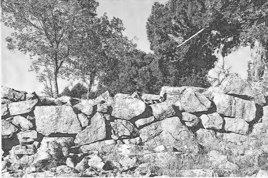
Res. 55 Ahmet Alanı Kalesi. Bölgedeki en iyi korunan kalelerden biridir. Kale surlarında genellikle temelde iri çokgen taşlar kullanılmıştır.
