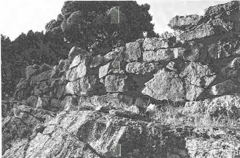
Res. 56 Ahmet Alanı Kalesi. Surların kimi noktalarında giriş açıklıkları ve kule temelleri görülmekte. Sur içi alanda ise niteliği kesin olarak anlaşılamayan yapılar planı çıkarılabilecek kadar korunmuştur. Ayrıca, kale surları içinde ve dışında düzenli bir seramik dağılımı izlenebilmektedir.
